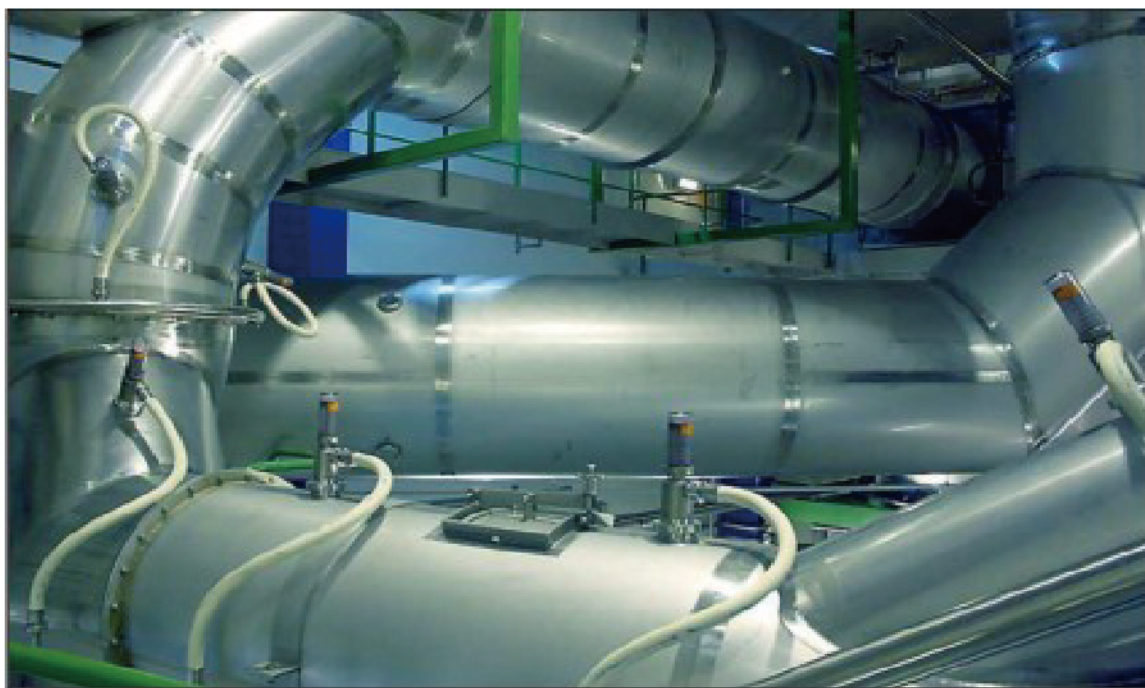
安装于管道的CIP喷嘴
